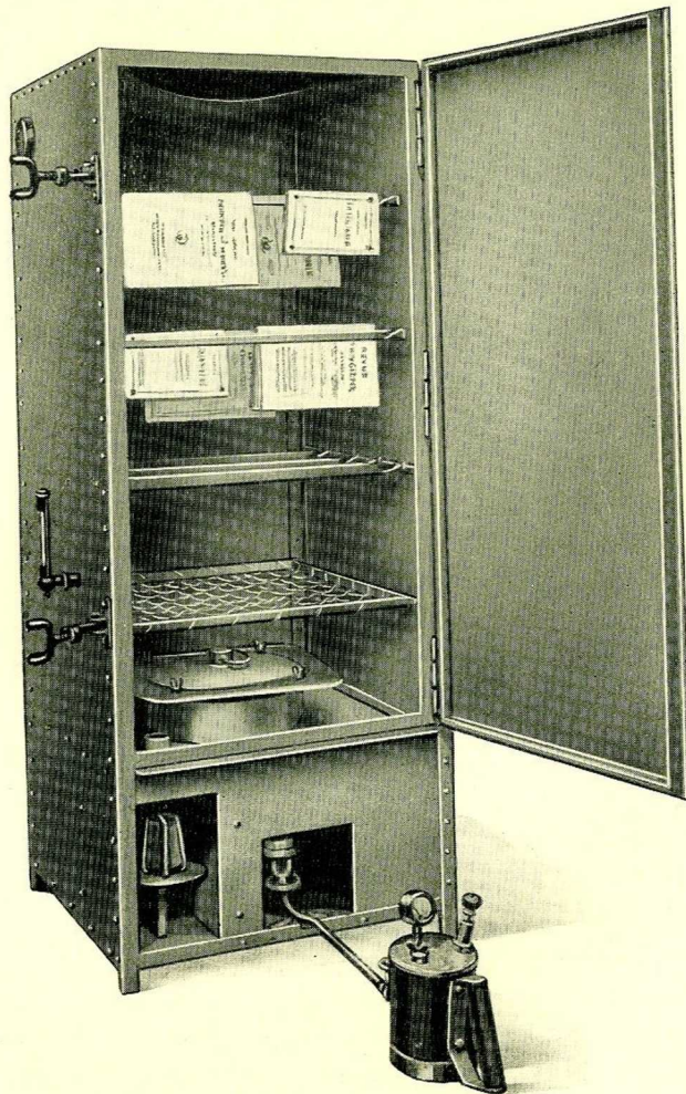
Fig. 10. — Armoire-Étuve à livres chauffée au pétrole.
